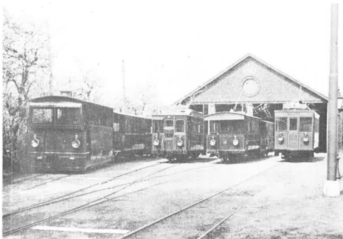
Zicht op loods 2. Trammuseum Schepdaal. Foto: Amutra vzw.
